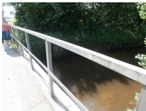
Broen over Holme Kanal ved Oved
